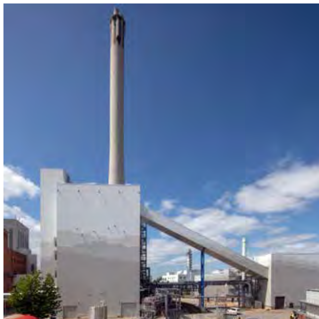
Möglich wurde der Kohleausstieg durch ein nachhaltiges neues Kraftwerkskonzept von BS|ENERGY: Das Steinkohleheizkraftwerk, das Strom und Wärme am Standort Mitte produzierte, wurde durch ein Biomasse-Heizkraftwerk mit dem Hauptbrennstoff Altholz in Kombination mit einem Gasturbinen-Heizkraftwerk ersetzt. Bild: Ulrich Reinicke
