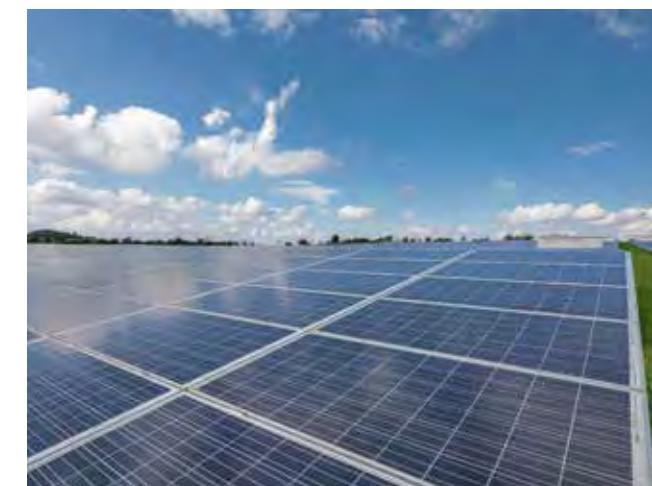
Schleizer Dreieck: BRAWO Green Energy betreibt in der Nähe des Ortes Schleiz, direkt an der A 9 in Thüringen, einen Solarpark. Auf einer Fläche von 15 Hektar sind 46.584 Solarmodule im Einsatz, die eine Leistung von 12 Megawatt Peak haben.
